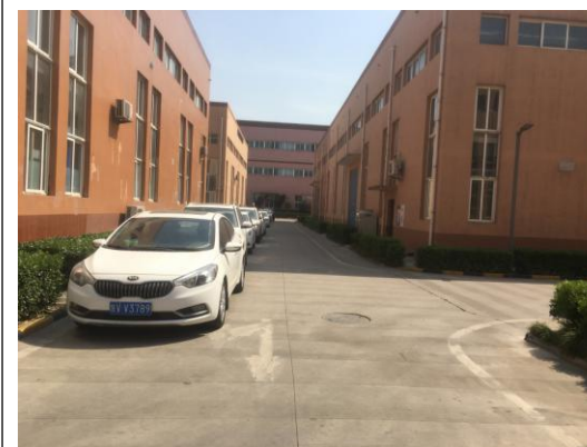
厂区东侧美畅新材料公司厂房
