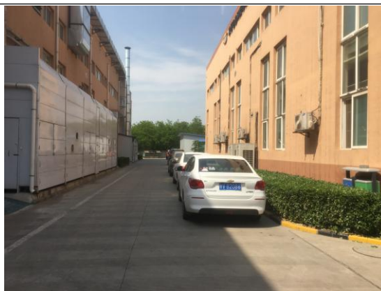
西侧陕西相信高科技有限公司厂房
