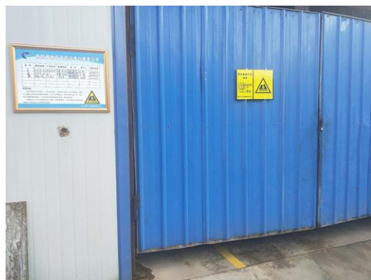
危险废物暂存间
