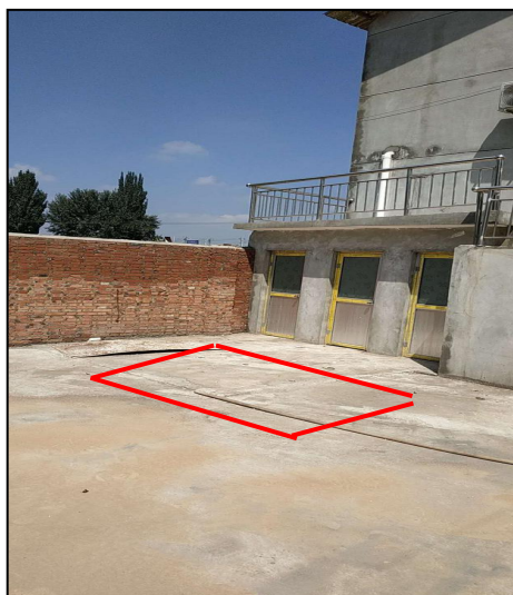
职工宿舍化粪池
