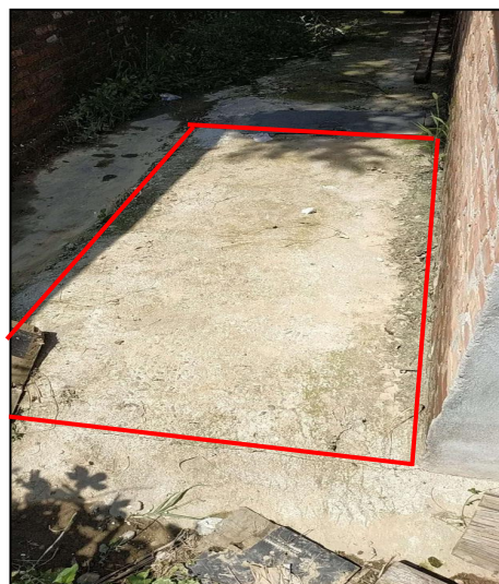
厕所澡堂化粪池
