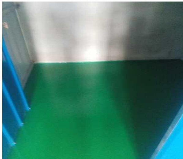
危废暂存间内部
